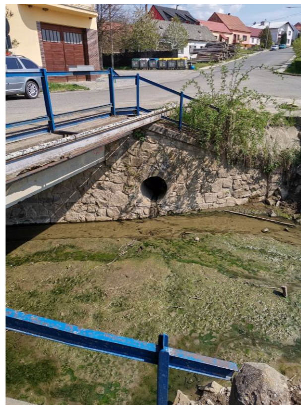
Vyústění stoky II
