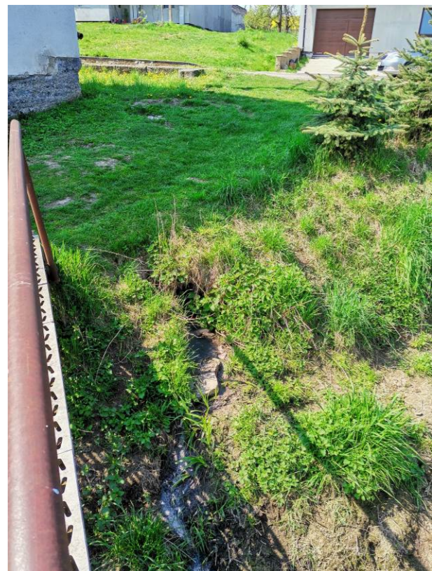
Vyústění stoky I
