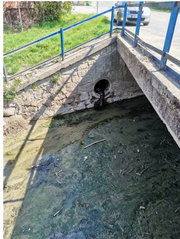
Vyústění stoky III
